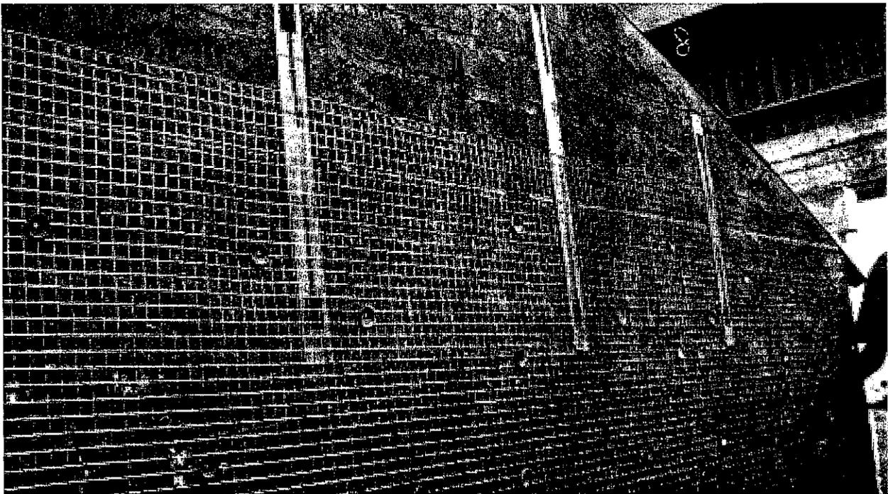
**Fig. 18. DOBLADO Y ENGRAPE DE LOS CONECTORES CONTRA LAS TABLAS DE REFUERZO EN UN TIMPANO DE ADOBE.**
